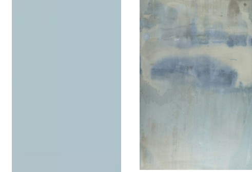
PEINTURE PLAFOND - Salle de bain Voute - Argile - Peinture decorative dégradée
